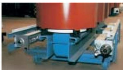
Трансформатор GEAFOL с установленными радиальными вентиляторами
